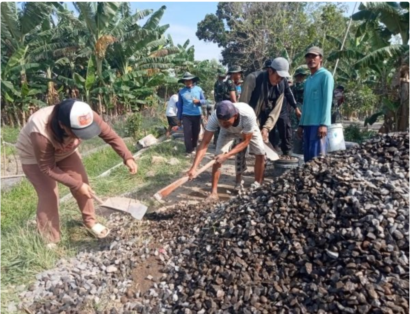
Antusias Warga Cangkring Dalam Pengeroran Jalan Sasaran TMMD
