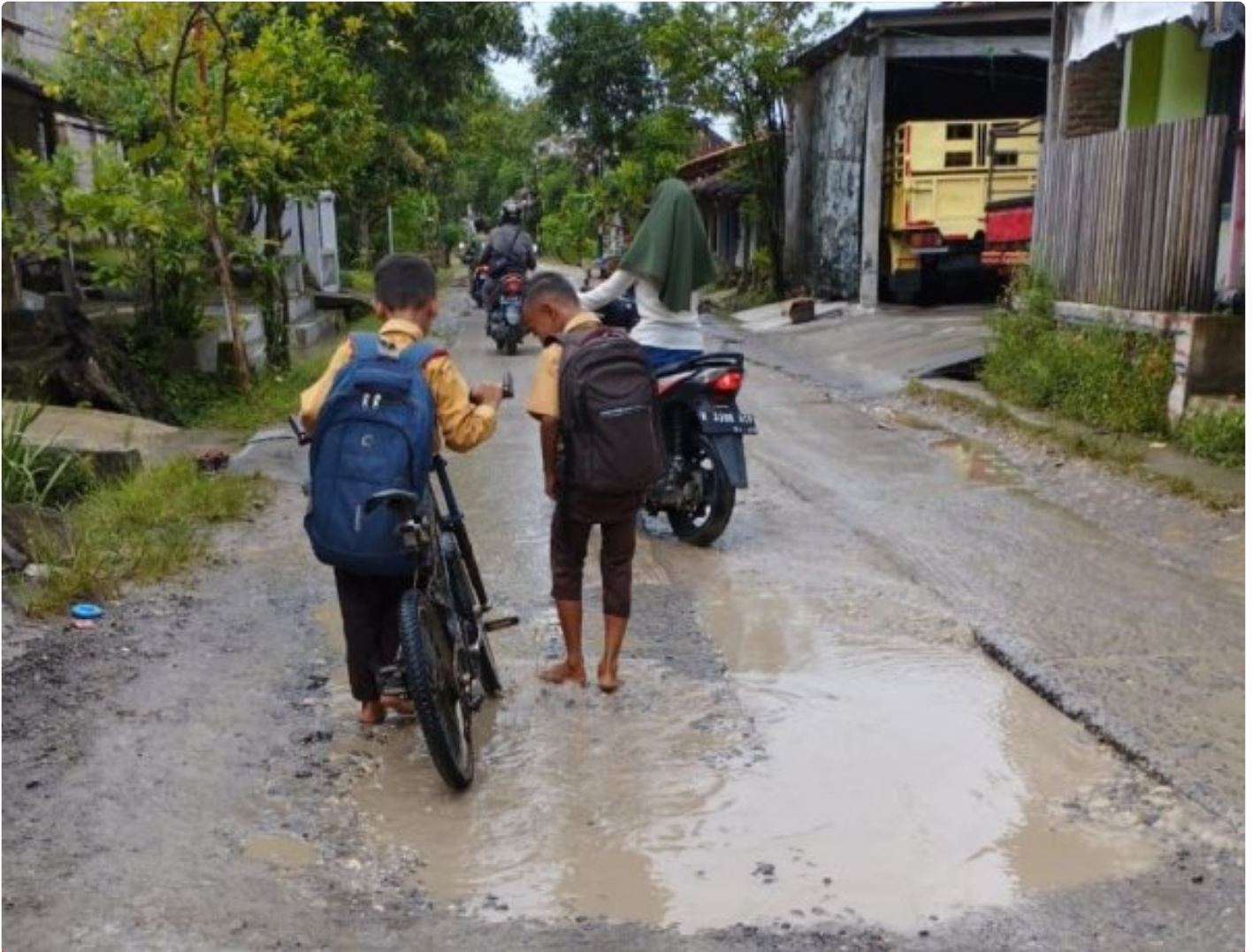
Siswa Terpaksa Berjibaku Melewati Akses Jalan Rusak Parah, Berlumpur, Menuju sekolah.
